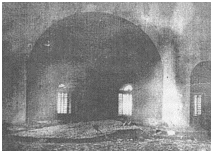
Алтарь Предтеченской церкви, где под слоем песка и штукатурки была найдена часть архива Тамбовского губвоенкома
